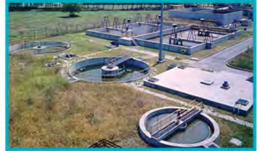
TOYOTASA A.Ş. Biyolojik Atıksu Arıtma Tesisi - ADAPAZARI 1994 4750 m 3 /gün Kapasiteli
